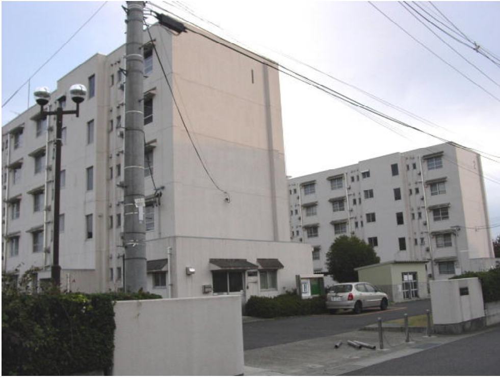
定住促進住宅外観
