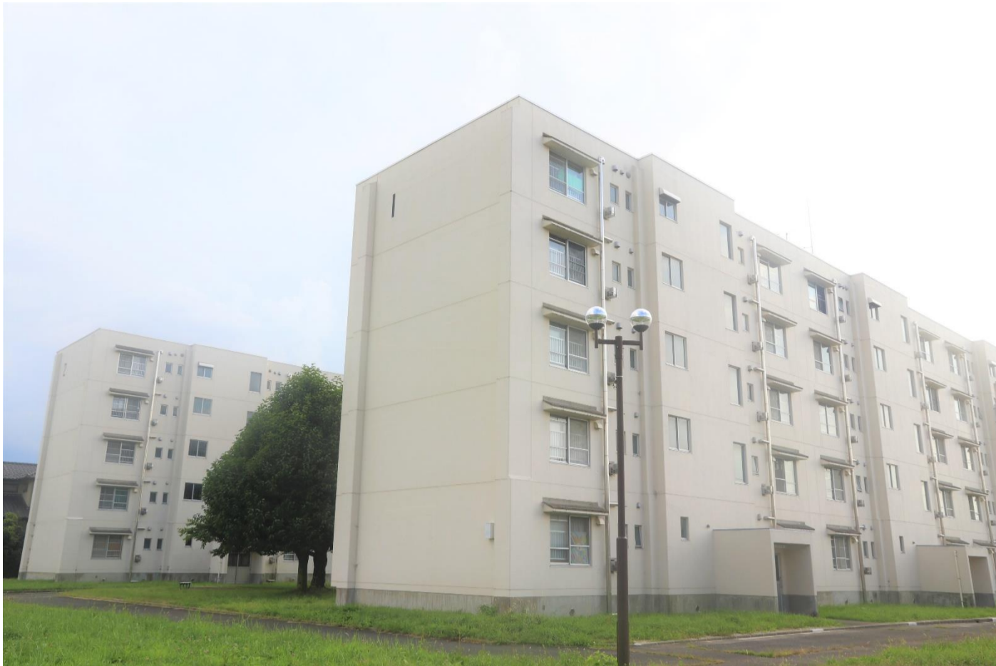
定住促進住宅外観
